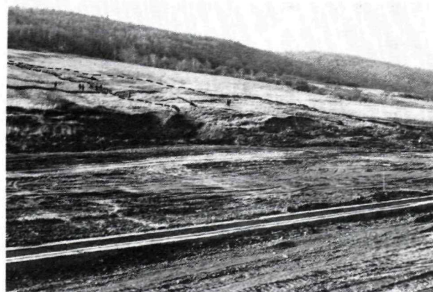
Obr. 2. Celkový pohľad na prúdový zosuv v Radvani nad Laborcom. Zreteľne vidno umelý zárez vo svahu a znehodnotenie splánírovanej plochy budovanej skládky dreva čelom zosuvu. Stav 28. 11. 1984.
